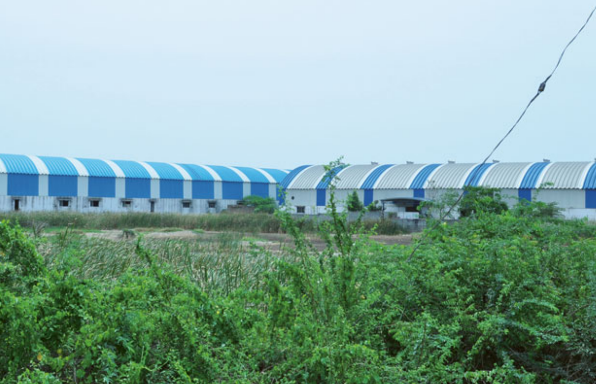
Stora Enso Inpacin vieressä sijaitseva Nefab-tehdas on asentanut katolleen sisäilman lämpötilaa alentavan ilmanvaihtojärjestelmän.
